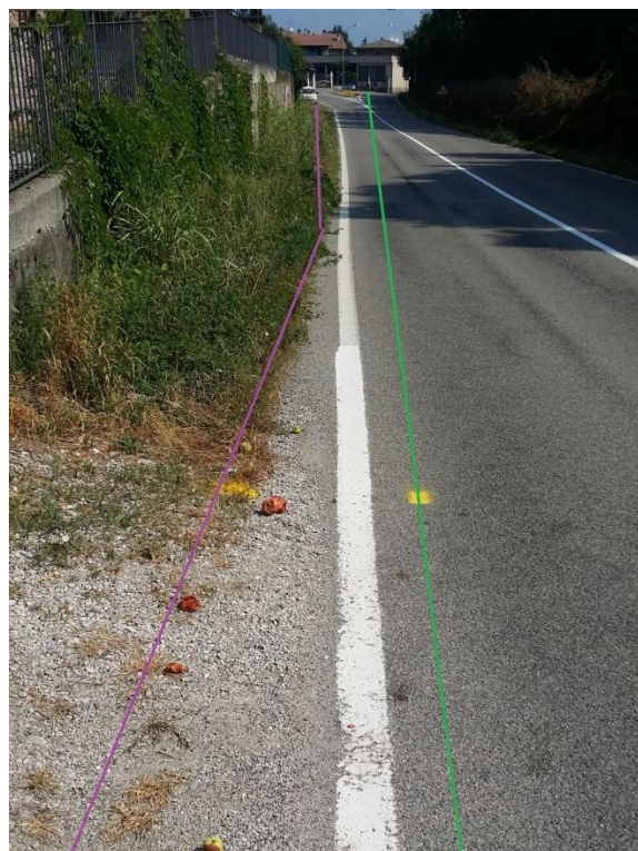
Figura 63 – Interferenze area 5 – a) elettricità Media Tensione; b) gas Media Pressione (in verde) e Bassa Pressione (in fucsia)
