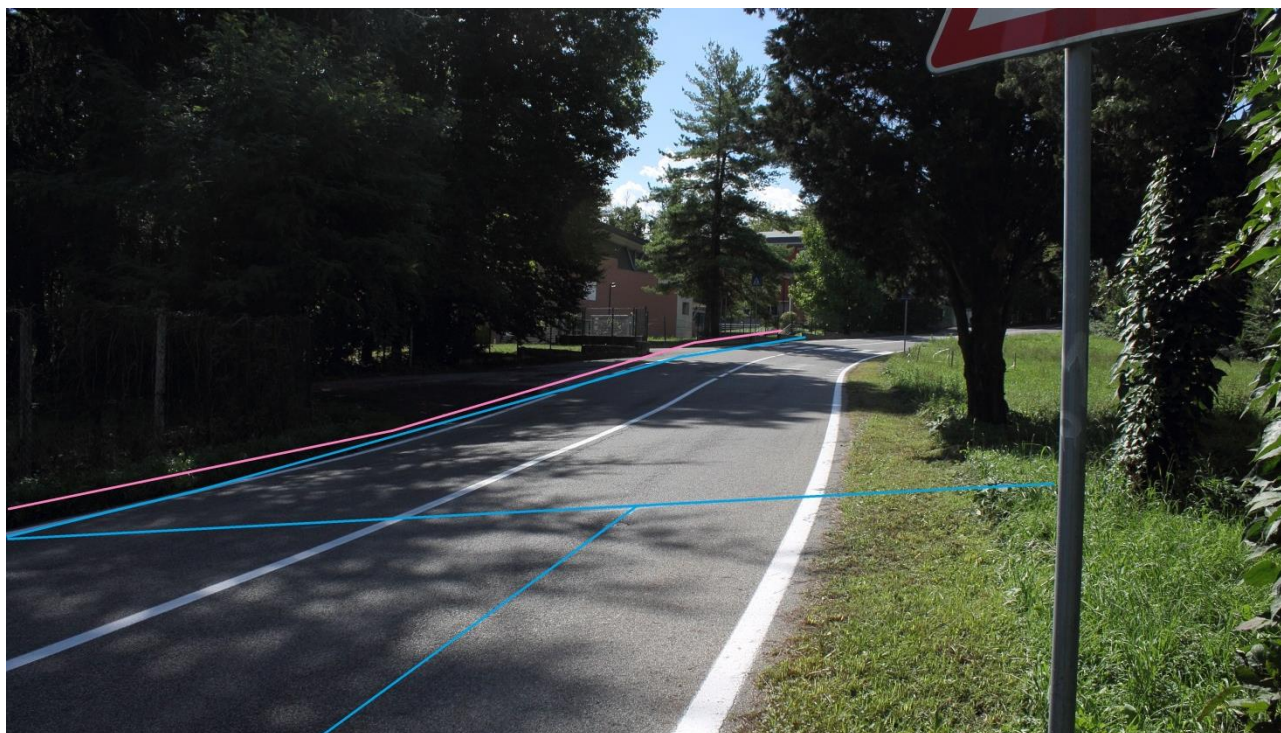
Figura 64 – Interferenze area 5 – rete Telecom (in rosa) e rete acquedottistica (in azzurro)
